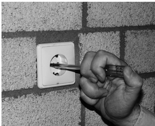
figuur 2.9 Zo gebruik je een spanningzoeker voor 230 en 400 Volt.
